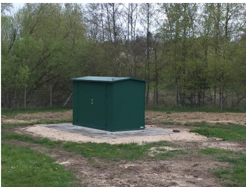
Boring 7 efter renovering
